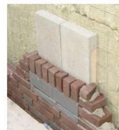
In metselen van prefab vleermuis kasten
