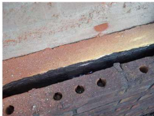
foto 1. Metselwerk uitgevoerd met een smalle baksteen
