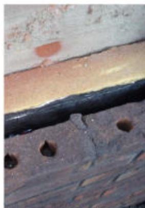
Gebruik van smalle baksteen bij renovatie
