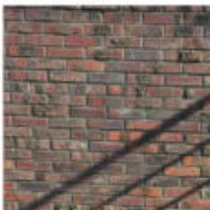
kade muur metselwerk
