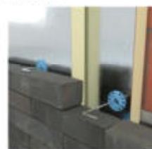
Afbeelding: L-vormig anker
