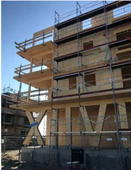
Project Mooijburg Plein, Amsterdam; Architect: Naturfied-architecture; Hoofdaannemer: Weever Bouw; Ingenieursbureau: Goudstikker – De Vries; CLT leverancier: Laminated Timber Solutions.
