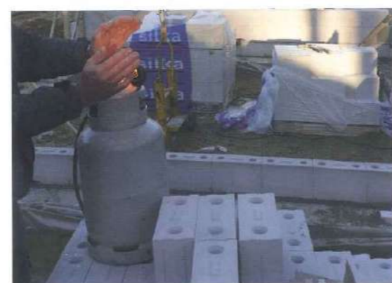
Voor het al dan niet doorwerken bij vrieskou is het vaak de mens die maatgevend is. Bij een gevoelsomtemperatuur lager dan -6 °C mogen werknemers het werk neerleggen.
