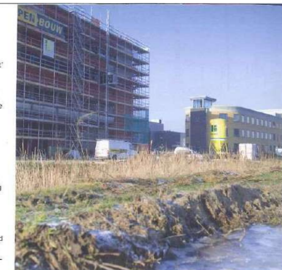
Vak wordt bij een (verwachte) dagtemperatuur van 5 °C of lager door metselbedrijven al gecertificeerd en overgeschakeld op het gebruik van vorstmortel.
