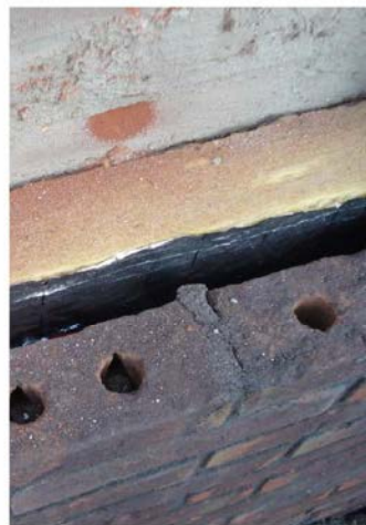
Gebruik van smalle baksteen bij renovatie
