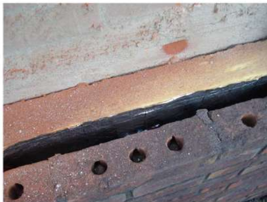
foto 1. Metselwerk uitgevoerd met een smalle baksteen
