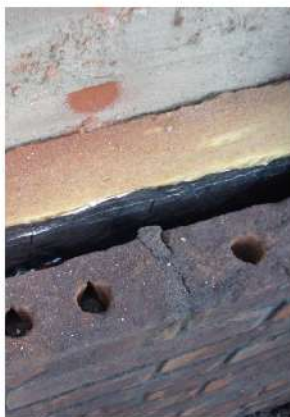
Gebruik van smalle baksteen bij renovatie
