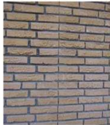
Fig. 2: minder fraaie uitvoering bij dilatatievoeg
